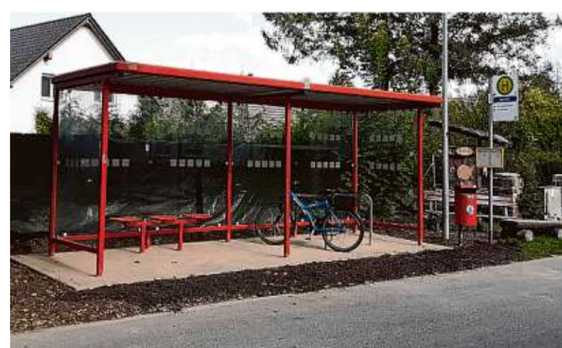
Schmucker Wetterschutz: Seit ein paar Tagen gibt es gegenüber dem Dorfplatz in Bernöwe diese recht große neue Bushaltestelle, die auch ein paar Fahrrädern Platz bietet. Foto: Stadt Oranienburg
